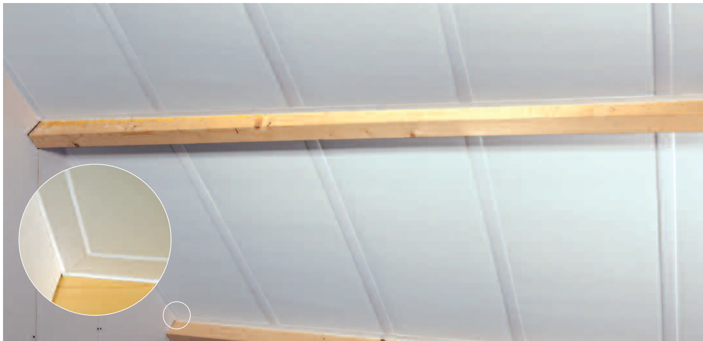
Hoekoplossing met in verstek gezaagde profielen.
